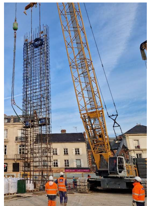
O-cellával ellátott armatúra beépítése.
